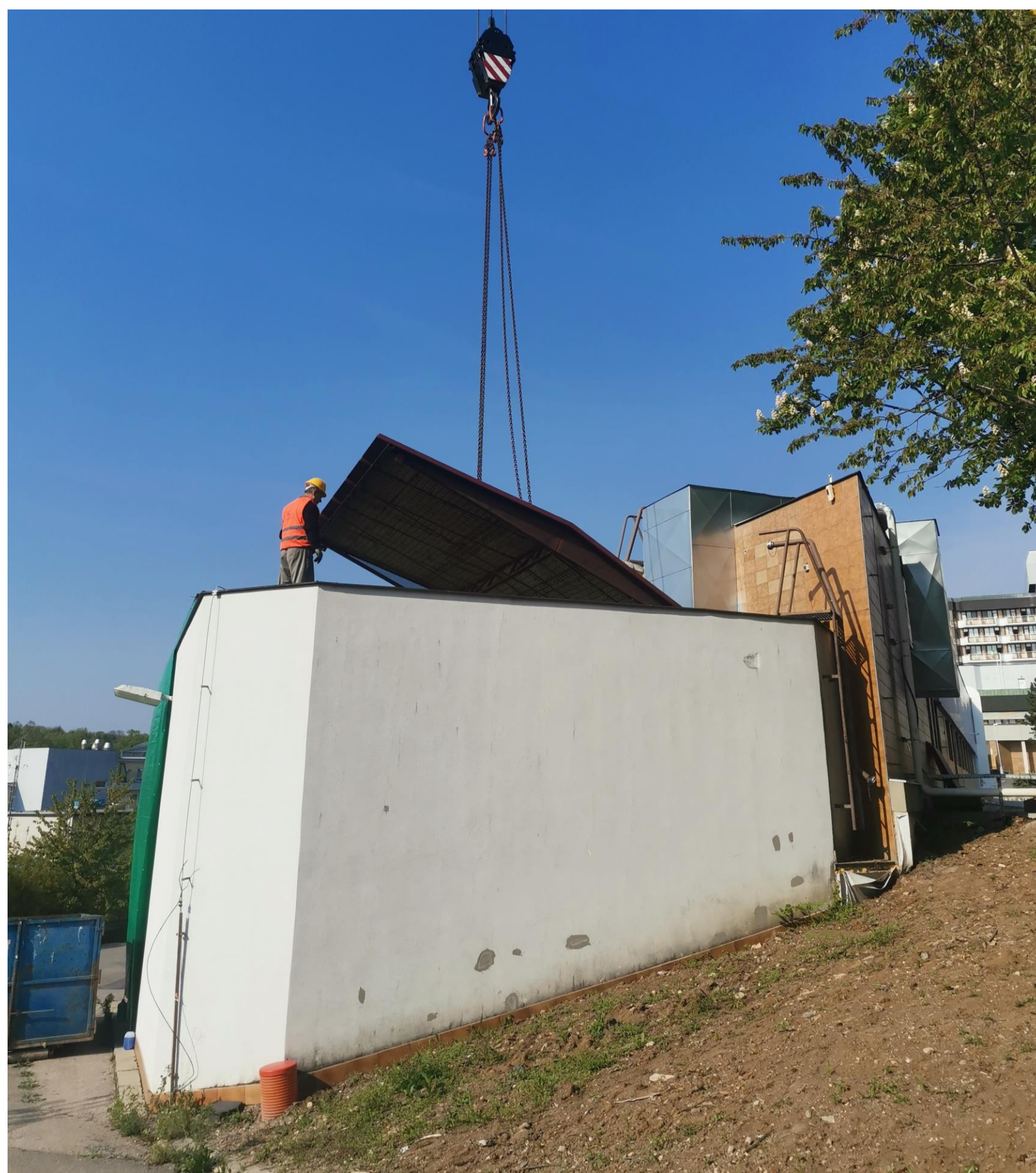
Odstranění ocelového překryvu
