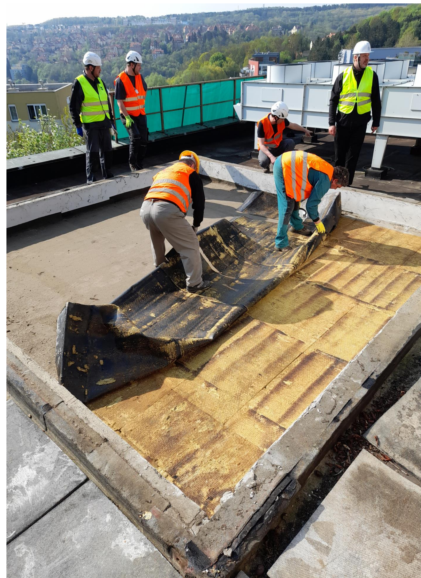
Odstranění hydroizolace
